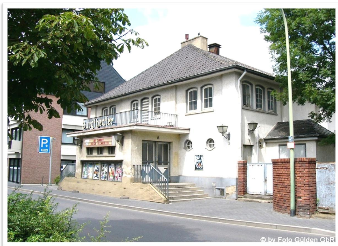
Foto: Mit freundlicher Genehmigung von "Gülden und Gülden GbR", Schumacherstraße 16, 53909 Zülpich www.fotoguelden.de
