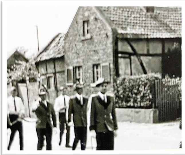
Haus Virnig , Hauptstraße in Geich, heute Aachener Straße 71.
